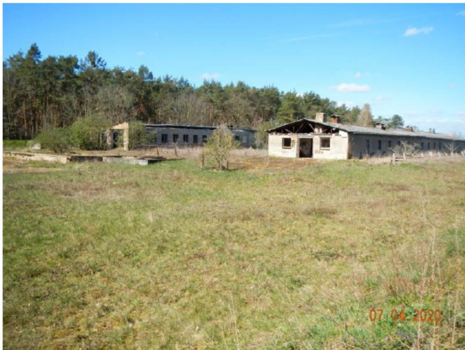
Blick von der südöstlichen Plangebietsgrenze auf die Reste der Stallanlagen und umgebende Ruderalfluren.
