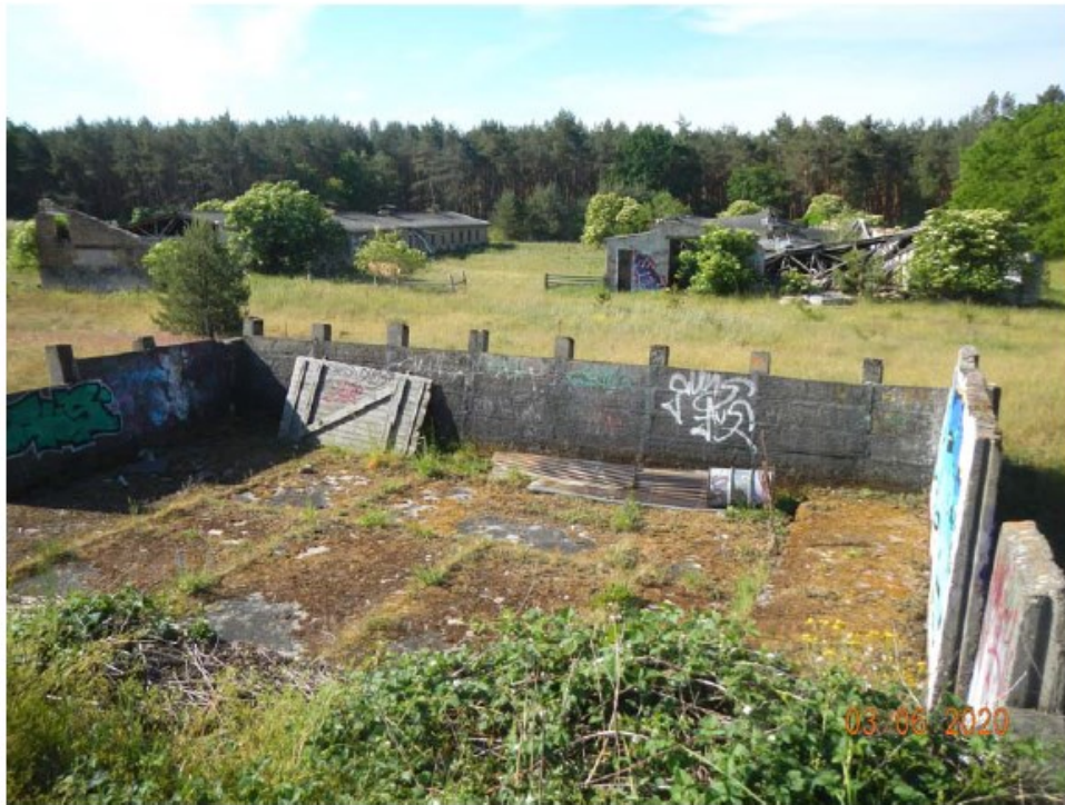
Blick von den Siloresten in das Plangebiet, im Hintergrund rechts das eingefallene westliche Stallgebäude (Aufnahme am 03.06.2020)
